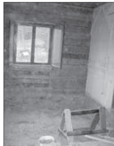
Prace remontowe na Bacówce rozpoczęły od zerwania podłóg i obicia tynku
