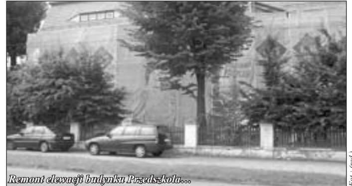
Remont elewacji budynku Przedszkola...
