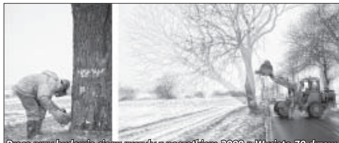
Prace przy budowie ciągu ruszyły z początkiem 2009 r. Wycięto 70 drzew
