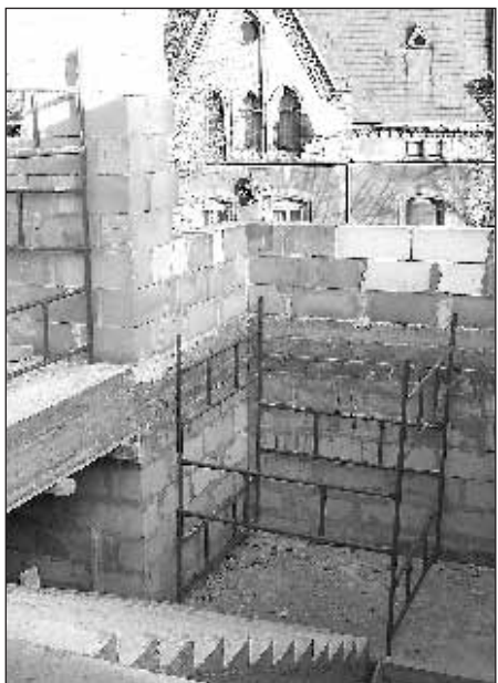
fot. (red.) - Do dnia dzisiejszego zrealizowano obiekt do poziomu pierwszego piętra
