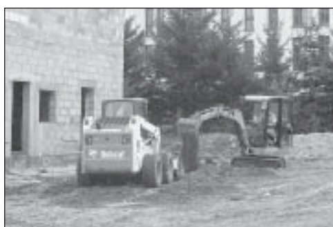
Tuż po podpisaniu dokumenty na placu budowy rozpoczęto prace
