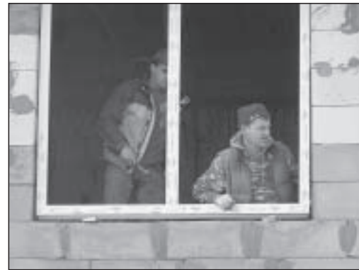
...i stolarka okienna to efekt prac ostatnich kilkunastu dni
