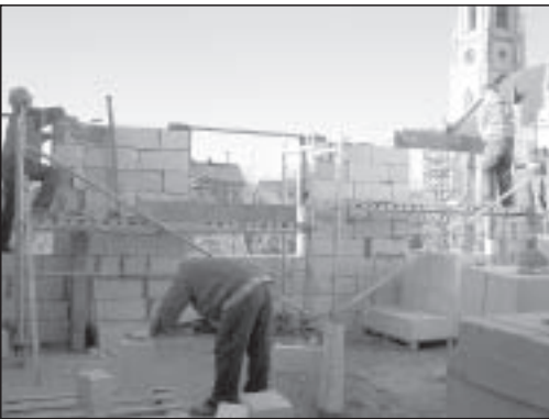
Widoczne prace murowe...
